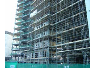
Sous-structure de façades
