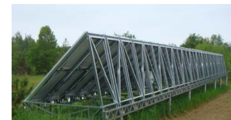
Structure de panneaux photovoltaïques
